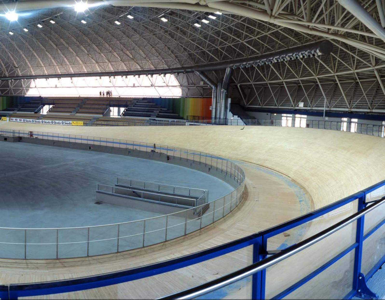
Il montaggio della struttura reticolare spaziale è stata un'acrobazia lunga due mesi e compiuta a 21 metri di altezza per infilare 6.528 profili tubolari su 1.605 nodi sferici, coprendo così una superficie di 9.200 mq ed un volume di 105.000 mc.
